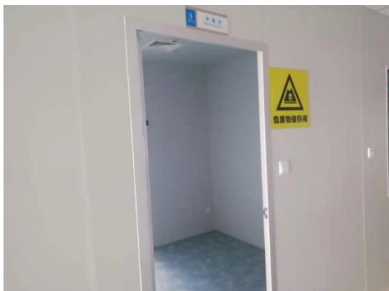
危废暂存间大门
